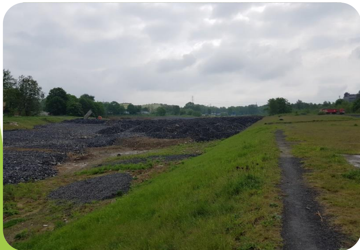
W trakcie rekultywacji
